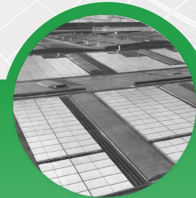
Estructura en Cubierta
