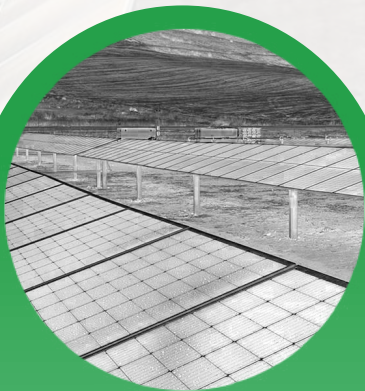
Estructura Seguimiento 1 eje
